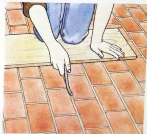
Tanto il cemento asciutto quanto quello bagnato vanno rifiniti e sigillati facendo scorrere un bastoncino lungo gli interstizi.
