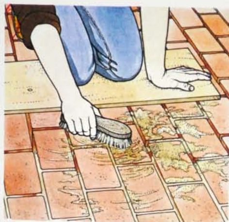
I mattoni possono venire cementati spazzolando, con una spazzola ruvida, malta asciutta dentro gli interstizi.
