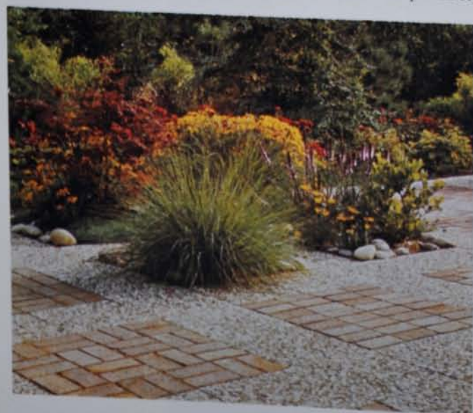
Qui si vedono dei lastroni di calcestruzzo che hanno la ghiaia esposta in superficie e sono messi in opera insieme ai mattoni.
